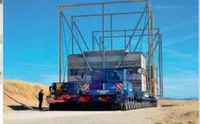
De eerste fase van de fundering van de fusiereactor. De 1,7 m hoge betonnen pilaren hebben een aardschaalsterke bouwlaag.
